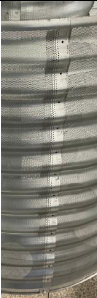
Abbildung 15: Parallele Überlappung.
