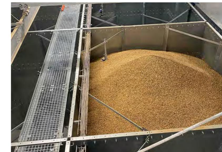
Silo mit Trichterunterbau
