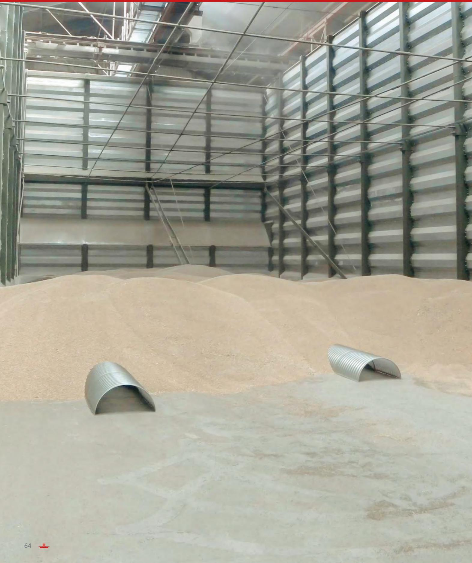
Halbrundkanäle | Semi-circular ducts | Les gaines demi-lune | Полукруглые каналы
