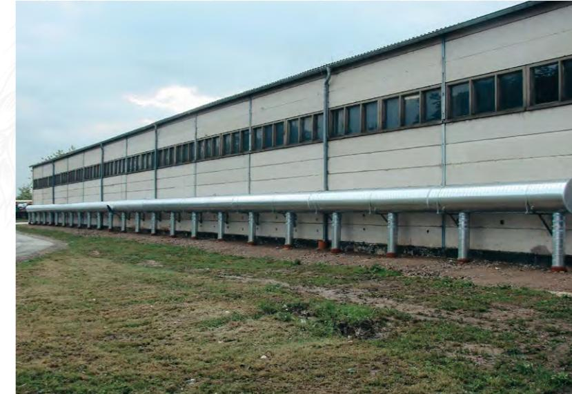
Hauptluftkanal mit abschließbaren Containeranschlüssen
