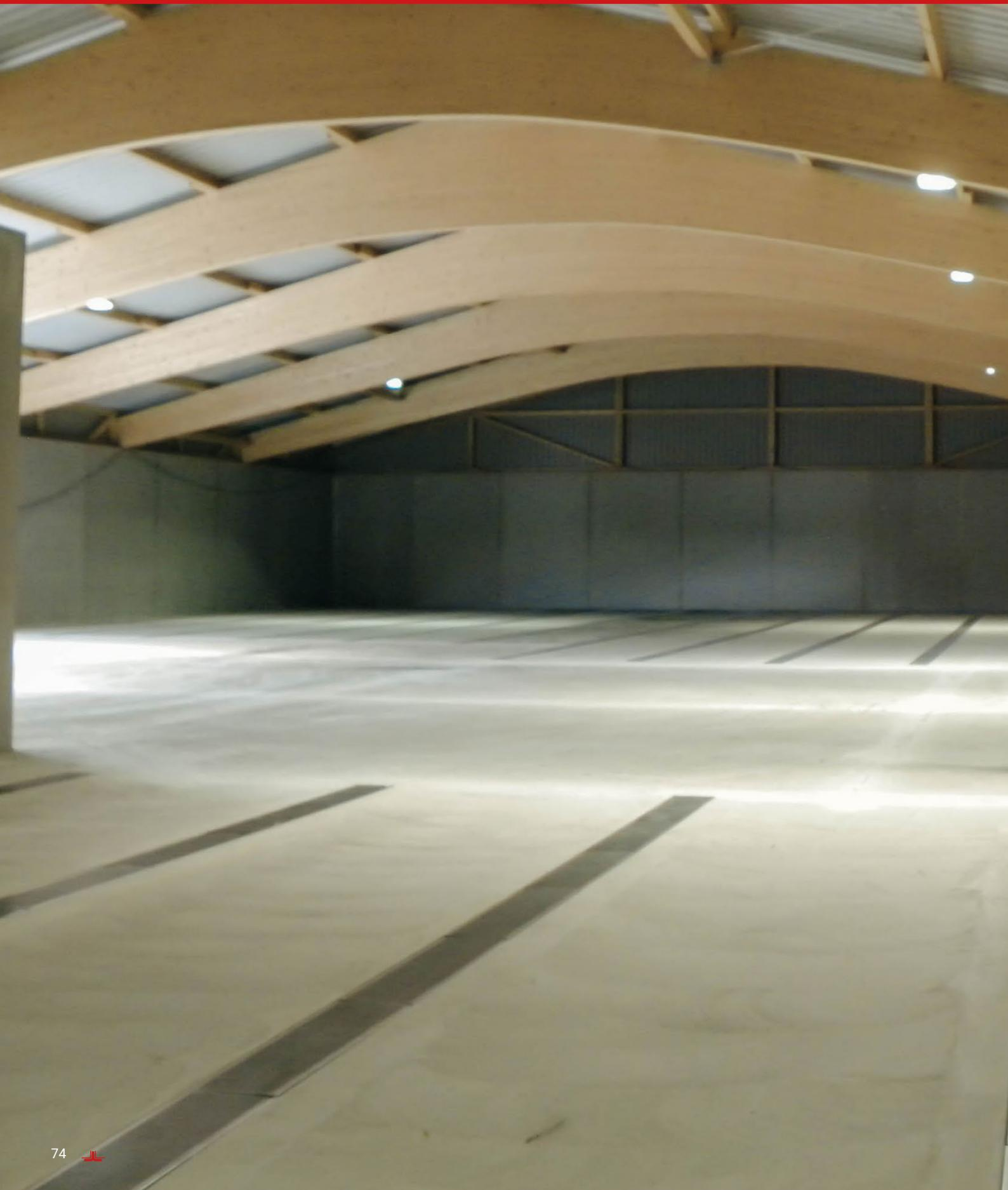
**Unterflurbelüftung | Underfloor ventilation | Caniveaux de ventilation | Подпольная вентиляция**
