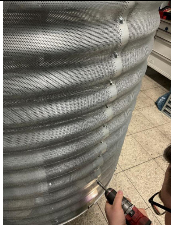
Représentation 16 : Fixation à l'aide de vis autoperceuses.
