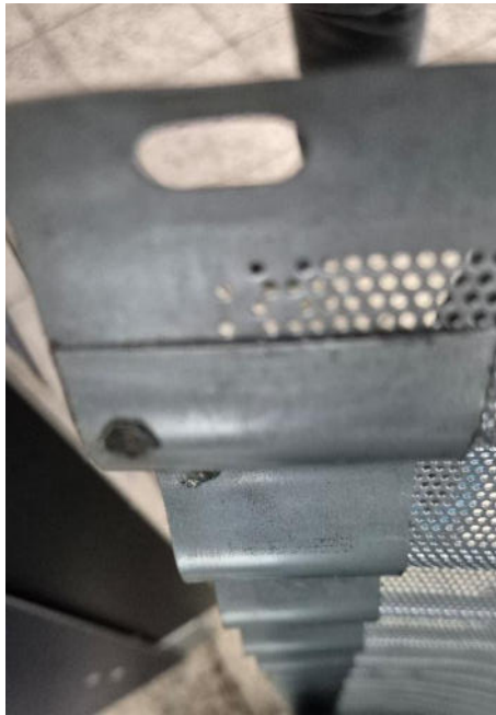
Рисунок 13: Усиление на наружном элементе, выполненное из перфорированного листового металла, должно располагаться с внутренней стороны.
