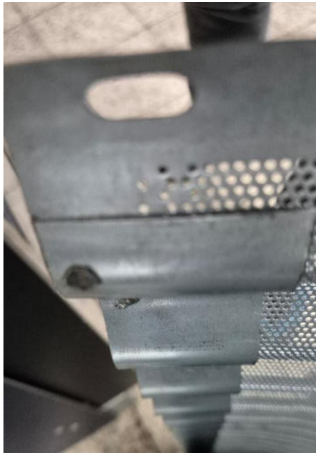
Représentation 13 : Le renfort en tôle perforée fixé sur le tube extérieur doit être placé à l'intérieur.
