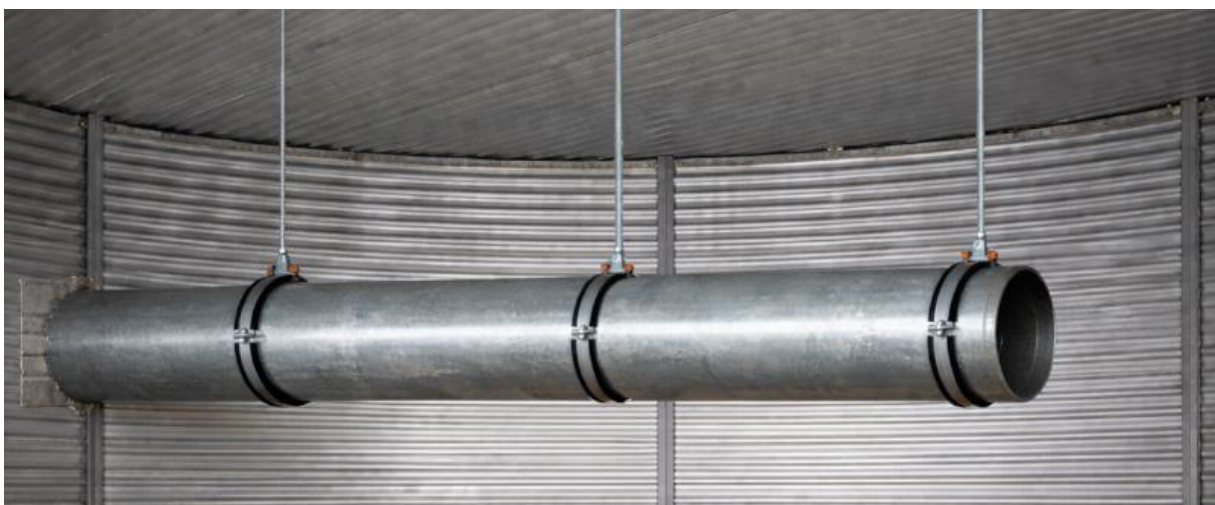
Représentation 25: Exemple de suspension de la conduite de ventilation. Peu importe que l'on utilise ici des colliers avec ou sans insert en caoutchouc
