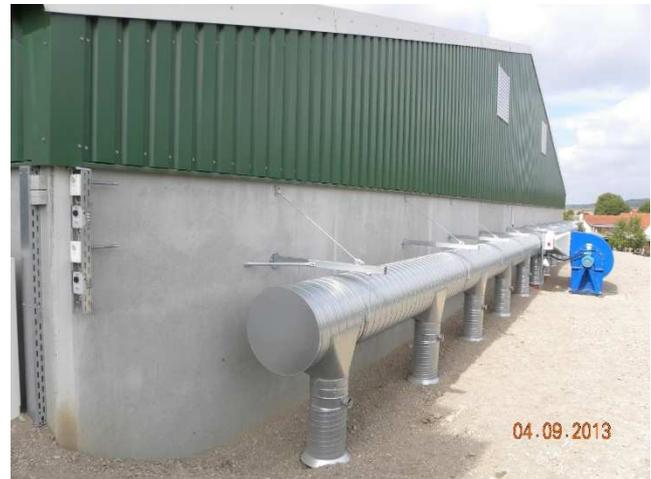
Avec ventilateur ASAIG et clapets pour le contrôle de la ventilation
