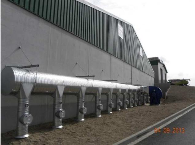
Canal principal fixé au mur et équipé de descentes allant jusqu'aux caniveaux de ventilation
