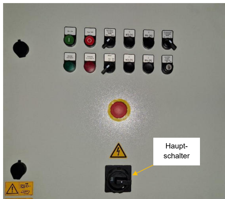
Abbildung 16: Schaltschrank.
