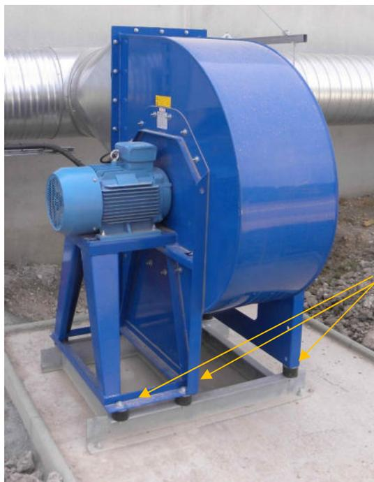
Gummipuffer unter allen Füßen verwenden!
