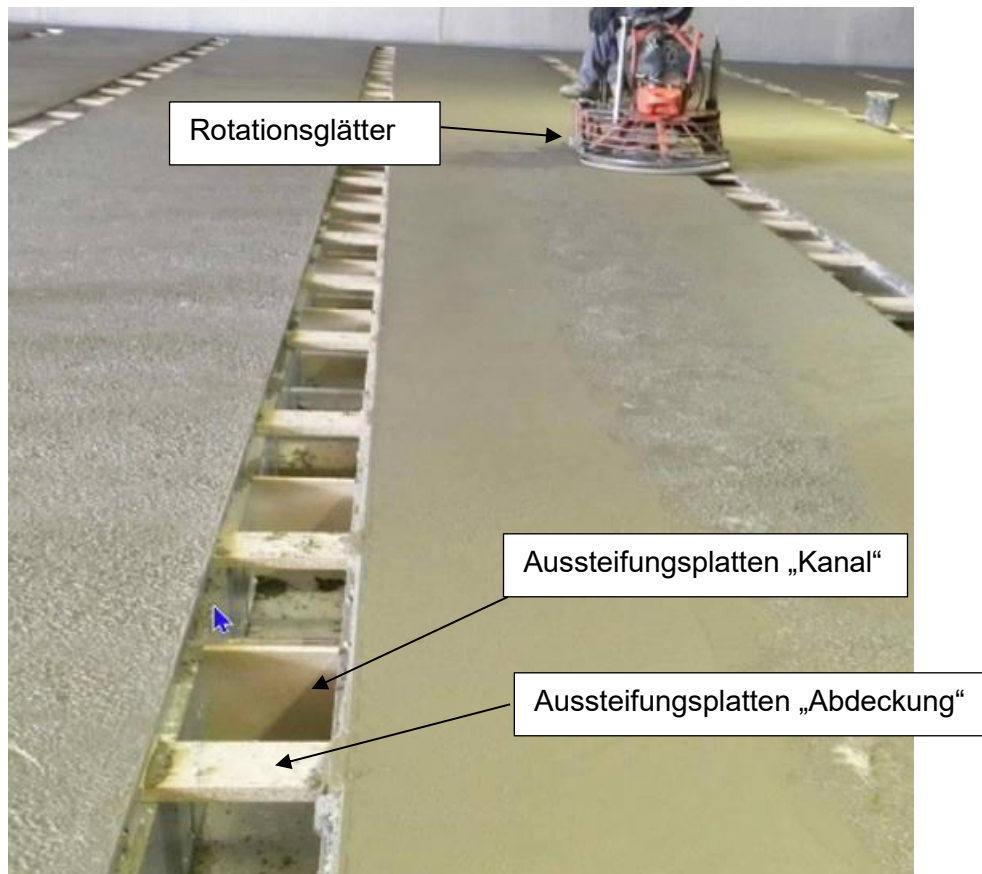
Abbildung 6: Temporäre Aussteifung
