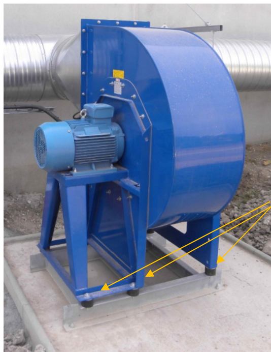
Représentation 4 : mettre des tampons en caoutchouc sous le ventilateur.
