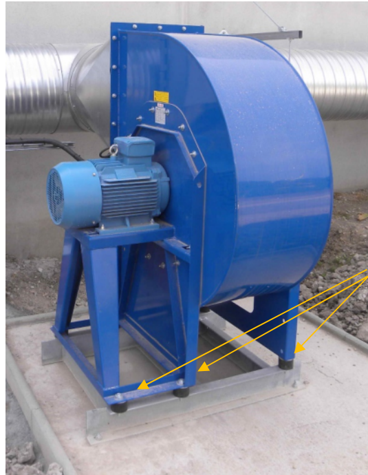
Abbildung 4: Gummipuffer unterhalb des Ventilators verwenden.
